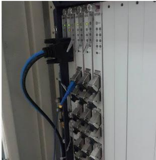
Contoh OLT (Optical Line Terminal) Untuk FTTH
